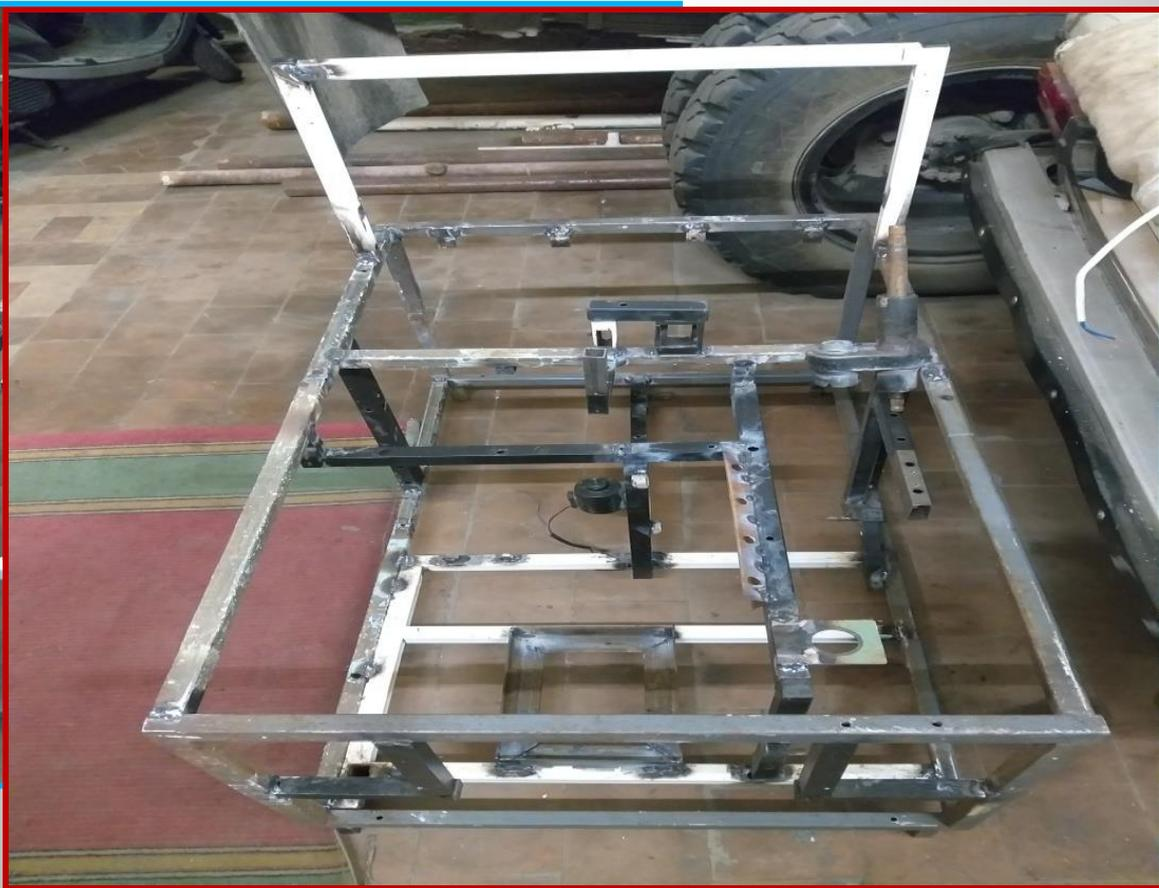
3. Мы приварили крепление генератора, стартера, вентилятора печки, ламп освещения салона и приборной панели. Сварены ножки и закреплены на каркасе.
